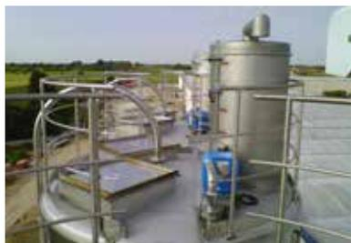
Filtrazione aria di carico e protezione ATEX
