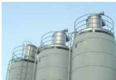
Filtrazione aria di carico e protezione ATEX
